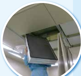
フィルター交換作業
