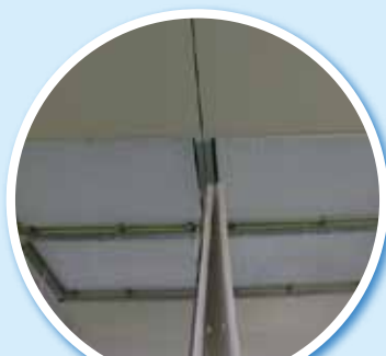
フィルター交換完了
